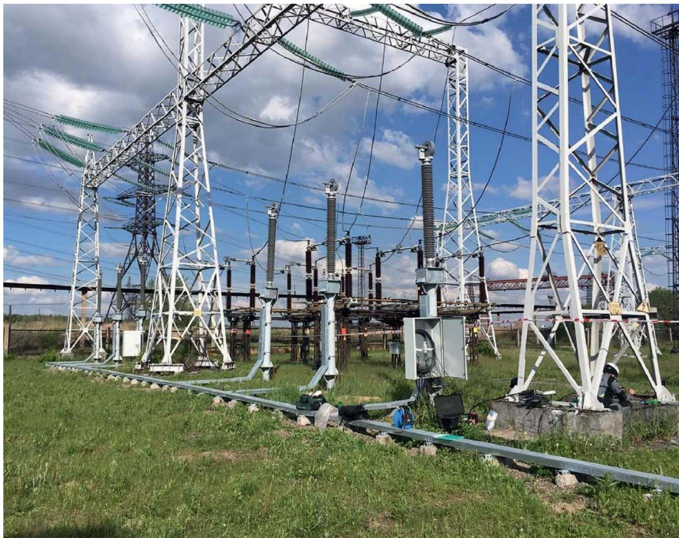
Рис. 3. Колонны с комбинированными электронно-оптическими трансформаторами тока и напряжения класса 220 кВ
