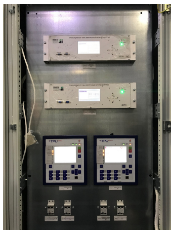
Рис.2 Шкаф АПВ КВЛ
