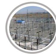
Передача и распределение электроэнергии
