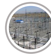
Передача и распределение электроэнергии
