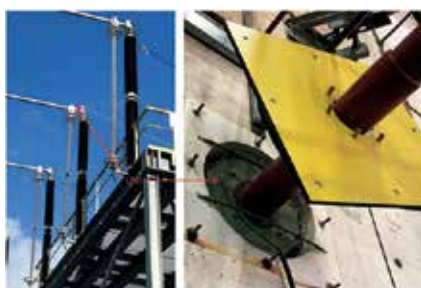
а) б) Рис. 8. Оптические трансформаторы тока в лаборатории КЕМА
