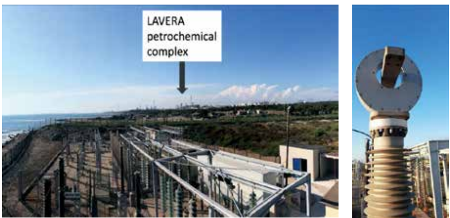
Рис. 17. ОТ Профотек, установленные на высоковольтных кабелях
