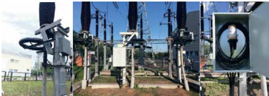
Рис. 19. ОТ Профотек, установленные на кабельных муфтах на ПС Герцево
